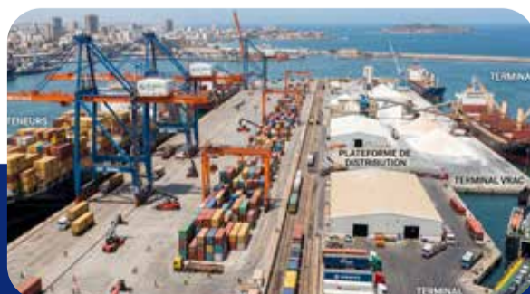
Opérations de Manutention
